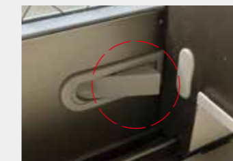
バルコニー窓に補助錠設置
