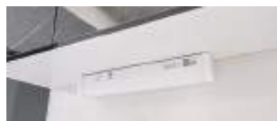
棚下にコンセント付照明設置
